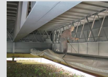
KefaTherm-Beschichtung einer Stahlkonstruktion
